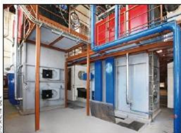
V rekonstruovaném centrálním zdroji tepla v Brumově-Bylnici fungují i dva kotle na biomasu o výkonu 1 a 2 MW.
