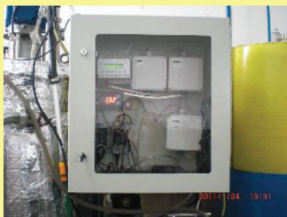
Фиг. 4. Сензори за CH 4 , CO 2 и H 2 в биогаза
