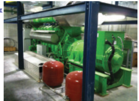
SYNGAS GENERATOR SET 1000 kW e
